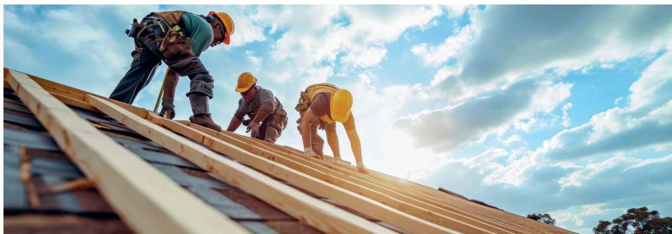
Mit der AK sicher am Dach arbeiten.
