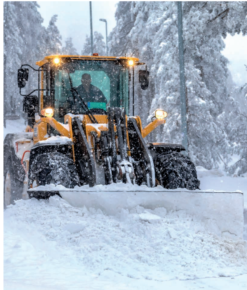
Bei Outdoor-Arbeiten im Winter können beheizte Fahrzeuge Schutz vor Kälte bieten.
