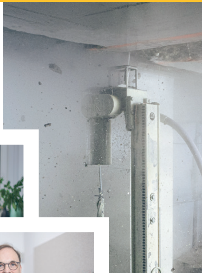
Der Roboter übernimmt den körperlich anstrengendsten Teil und wird von zwei Beschäftigten abwechselnd bedient.
