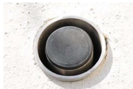
Bodenhülse mit Stempel gegen Stolpergefahr
