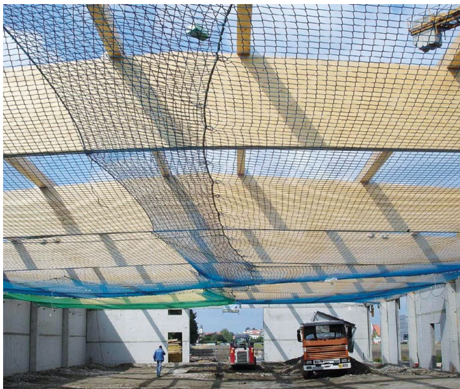
Schutznetz als Sicherung bei der Dachherstellung.
