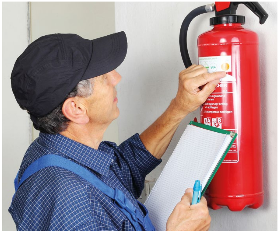
Ein Brandschutzbeauftragter bei der Überprüfung des Feuerlöschers.
