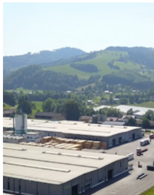
Luftaufnahme Fa. Mosser Leimholz mit Konferenz- und Schulungsgebäude am Fohlenhof 2.
